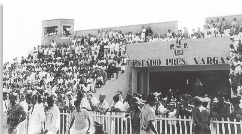
Foto 10 - Detalhe do estádio Presidente Vargas. Arquibancada de cimento armado, lugar especial, vendo-se ao alto à esquerda, cabine da imprensa. (Arquivo Nirez).
