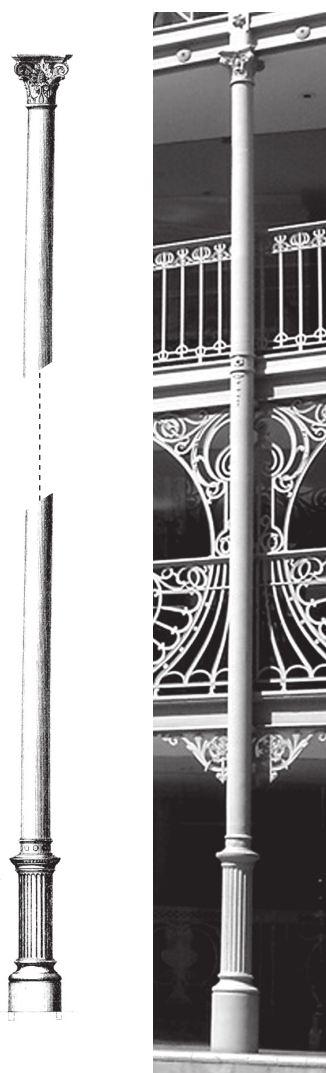
Figura 8b. Coluna nº. 156 , aplicada no Teatro José de Alencar. Observar parte de conduto de gás de iluminação, ainda mantido após o emprego de iluminação elétrica. (Foto: F. Veloso).
