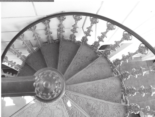
Figura 11c. Escada helicoidal nº. 639 (piso dos degraus), aplicada no Teatro José de Alencar. (Foto: F. Veloso).
