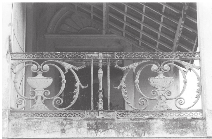
Figura 33. Casa de Raimundo Borges. Varanda (já então coberta) com gradis nº. 1093, procedentes do Teatro José de Alencar. Detalhe. (Foto: Arquivo do Autor).
