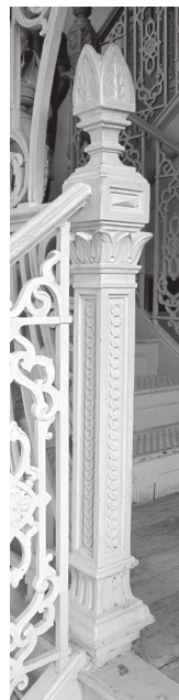
Figura 7b. Arranque de corrimão nº. 968 , aplicado no pavimento térreo do Teatro José de Alencar. (Foto: F. Veloso).
