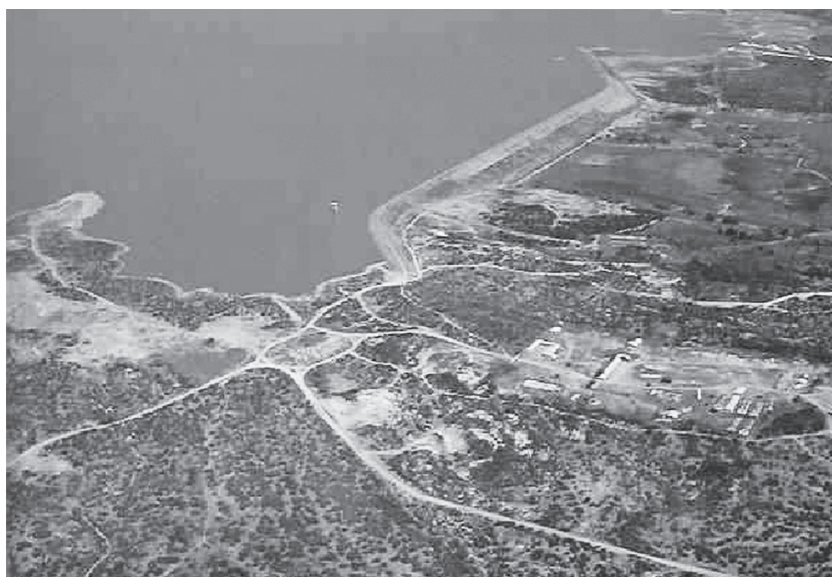
Figura 5 – Vista aérea da barragem e parte do açude Açú, no baixo curso do rio Açú (RN). Cortesia do Departamento Nacional de Obras Contra as Secas (DNOCS).
