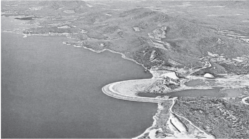
Figura 6 – Vista aérea da barragem e parte do açude Orós, na microrregião de Iguatu (CE). Cortesia do Departamento Nacional de Obras Contra as Secas (DNOCS).
