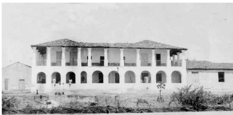
Figura 9 - Pensão Neco. Canindé, CE. Fachada de fundos, com arcaria no térreo e colonata no pavimento superior (ver figs. 7 e 8). Foto J. J. Rescala, 1941. Arquivos IPHAN.
