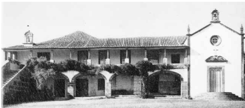
Figura 8 - Casa da Fervença. Barcelos, Minho. Portugal. Casa rural dos anos finais do século XVIII, obra singela com arcaria ao rés do chão e colonata na planta alta. Foto: AZEVEDO, 1969, p. 136 / estampa 79.
