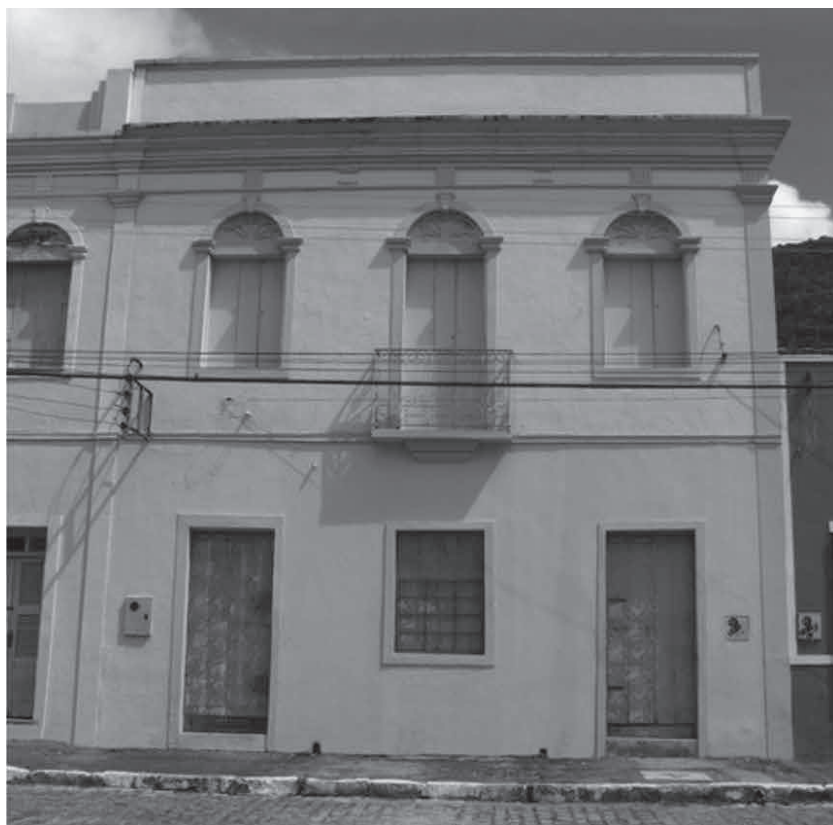
Figura 5 – Fachada do Sobrado da Abolição antes da reforma 20
