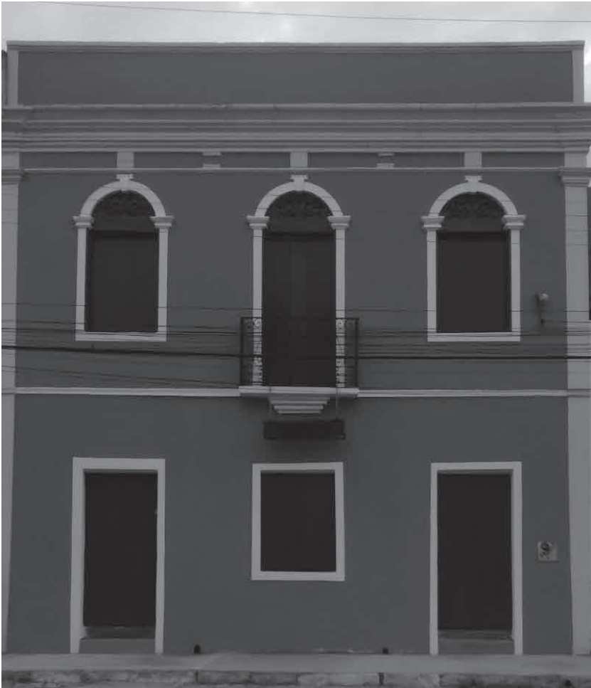
Figura 5 e 6 – Fachada do Sobrado da Abolição depois da reforma 21
